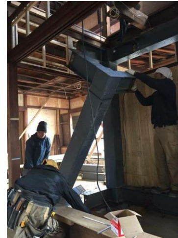
▲建物を補強する鉄骨の組み立て作業の様子。文化財としての価値を損なわないことはもちろん、安心安全に利用してもらうためにしっかりと補強しています。
