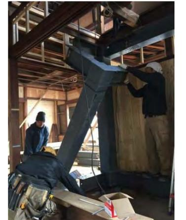
▲建物を補強する鉄骨の組み立て作業の様子。文化財としての価値を損なわないことはもちろん、安心安全に利用してもらうためにしっかりと補強もしています。
